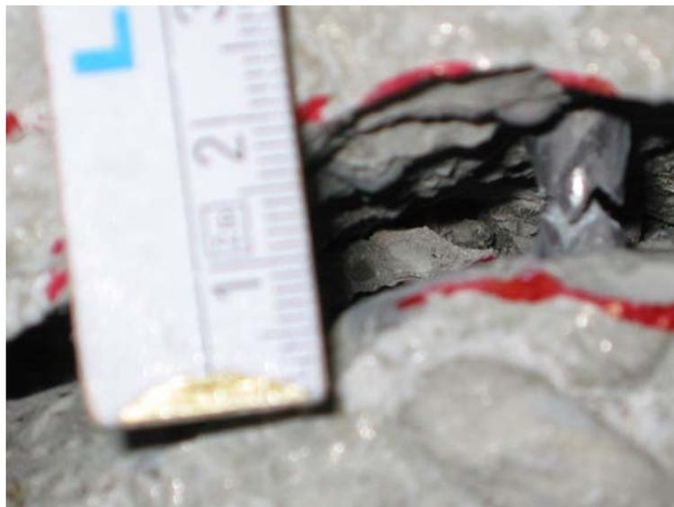
Bild 4.12: Gerissene Stützbewehrung
