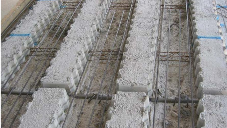
Bild 4.10: Eingelegte Stützbewehrung in die Stegzwischenräume
