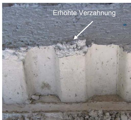
Bild 2.3.1.2: Erhöhte Stegverzahnung
