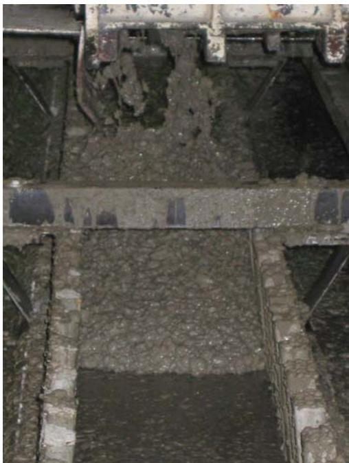
**Bild 3.1.1:** Verfüllen der Stege mit hochfestem, selbstverdichtendem Beton
