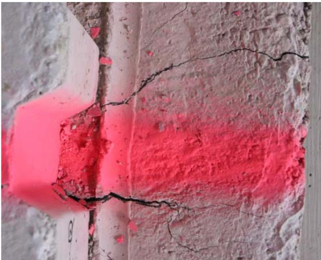
Bild 2.2.3.1: Rissbildung an der Plattenoberseite und Plattenrand
