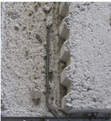
Die Stegverbundplatte hatte ein Eigengewicht von  $2,34 \text{ t}$ , das fast dem rechnerischen Gewicht von  $2,35 \text{ t}$  entsprach. Am Auflagerbereich A hatten drei Bewehrungsstäbe zur Plattenoberseite hin keine bzw. keine ausreichende Betondeckung. Dies war auf einen unsachgemäßen Einbau bei der Herstellung zurückzuführen, wie dies das *Bild 2.8.1.2* beispielhaft an einem Bewehrungsstab zeigt.
