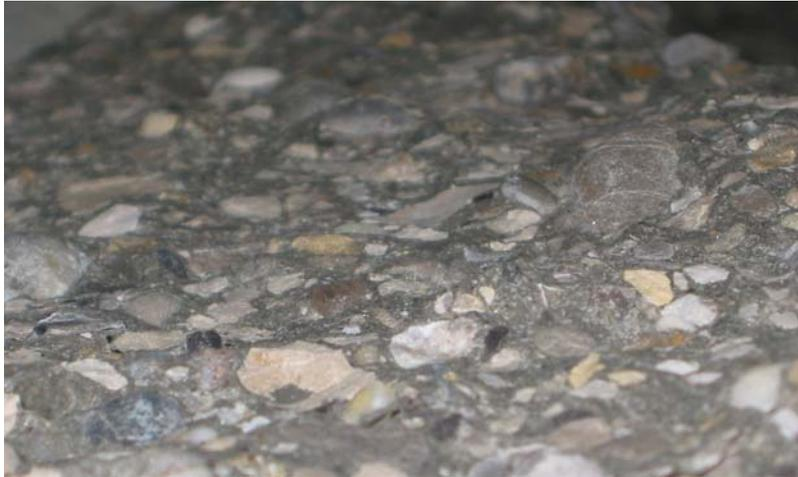
Bild 3.3.3.3: Zerstörte Zuschlagstoffe durch das Versagen der Druckzone
