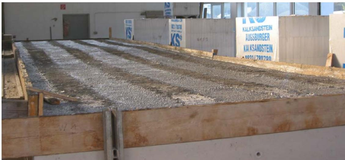
Bild 2.9.2.1: Eingeschaltete SVP 7 und 8 als Durchlaufträger
